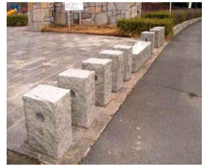
Granito trinkelės paviršius gali būti pjautas, degintas, apdirbtas dantytkūju (bučerduotas)
